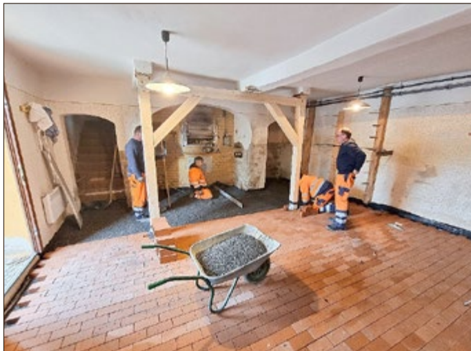
Die Mitarbeiter des Bauhofes legen die Pflasterfläche.
